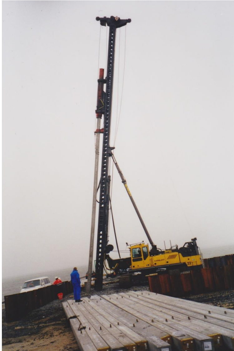
Betonpæle til pilotering af fundament
