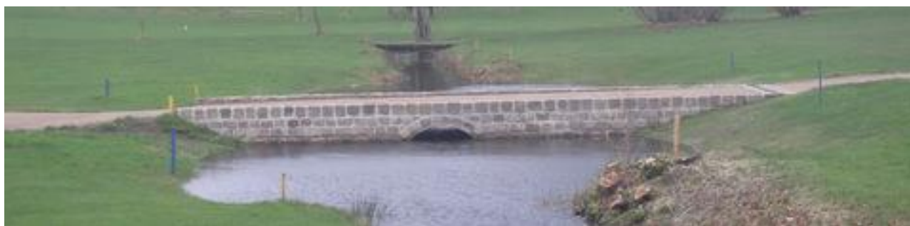
"Femmeren under test ved høj vandstand.
